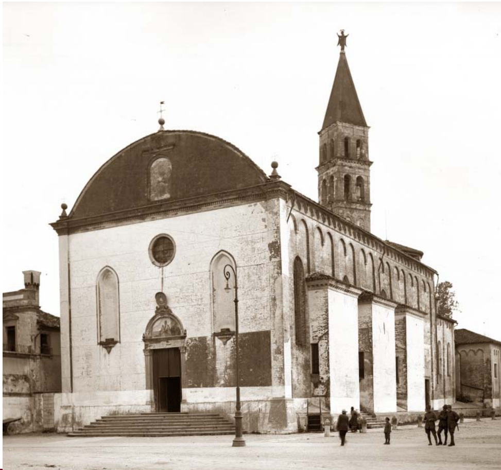
Prima del grande restauro
